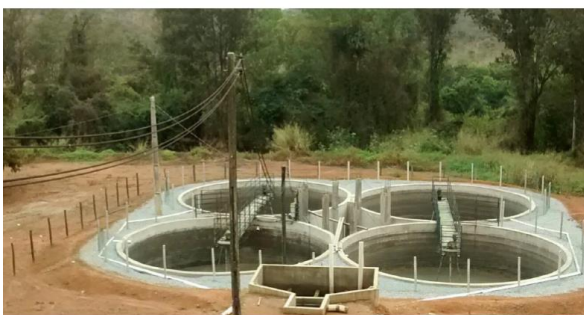
Foto 03. Tanque redondo (Agitação) da ETE - Latitude: 20°18'48.62", Longitude: 4°50'21.00"
