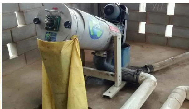
Foto 04. Prensa da ETE - Latitude: 20°18'48.62"S, Longitude: 44°50'21.00"O.
