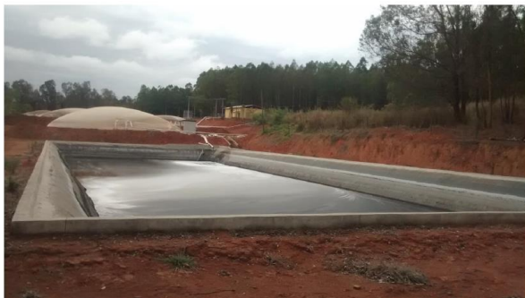
Foto 07. Lagoa de decantação da ETE - Latitude: 20°18'50.07", Longitude: 44°50'31.03"
