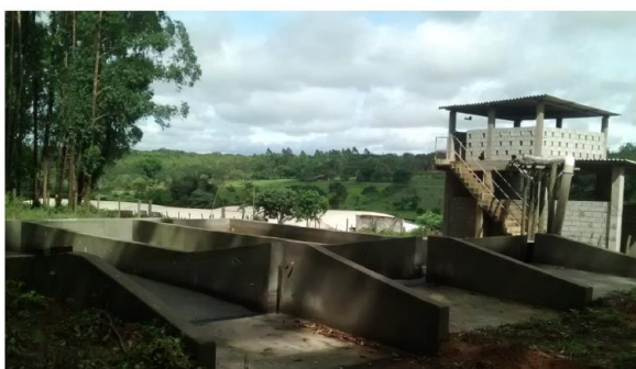
Foto 05. Leito de secagem da ETE - Latitude: 20°18'48.62"S, Longitude: 44°50'21.00"O
