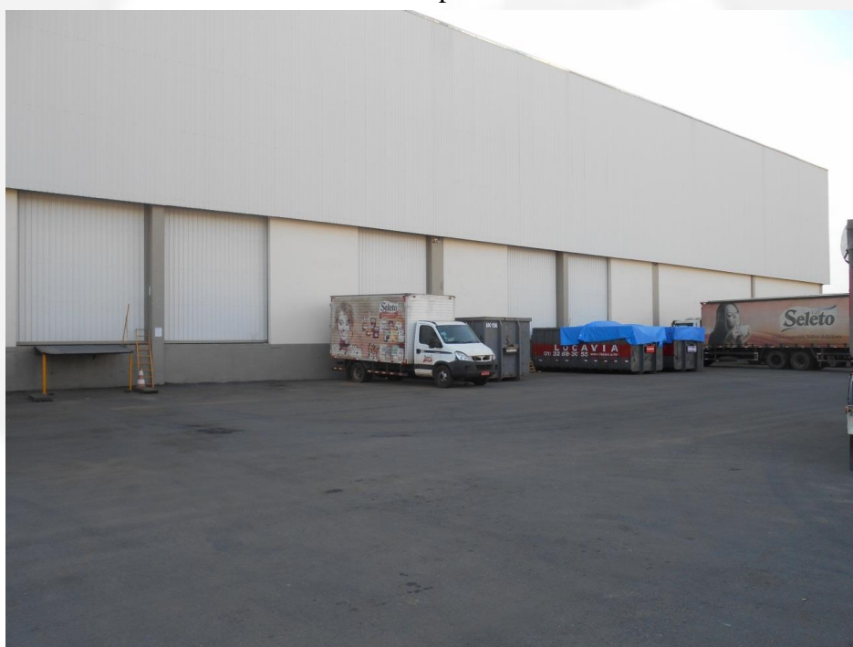
Vista geral externa
