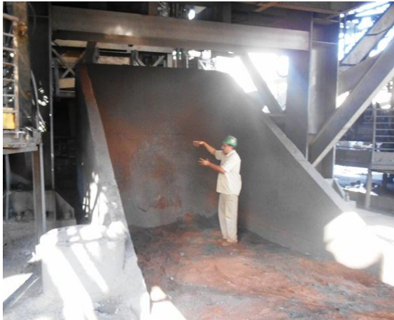
Foto 05. Baía para armazenagem temporária da escória.
