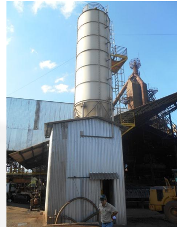
Foto 06. Silo para armazenagem dos fundentes.
