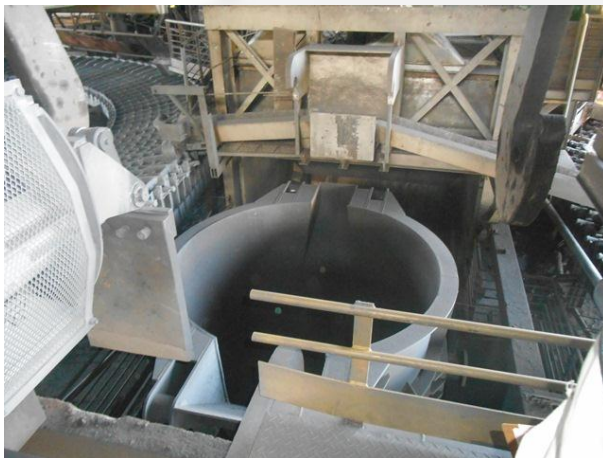
Foto 01. Panela para tratamento do gusa.
