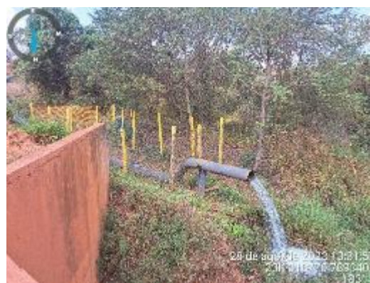
Foto 04. Ponto de restituição de vazão
