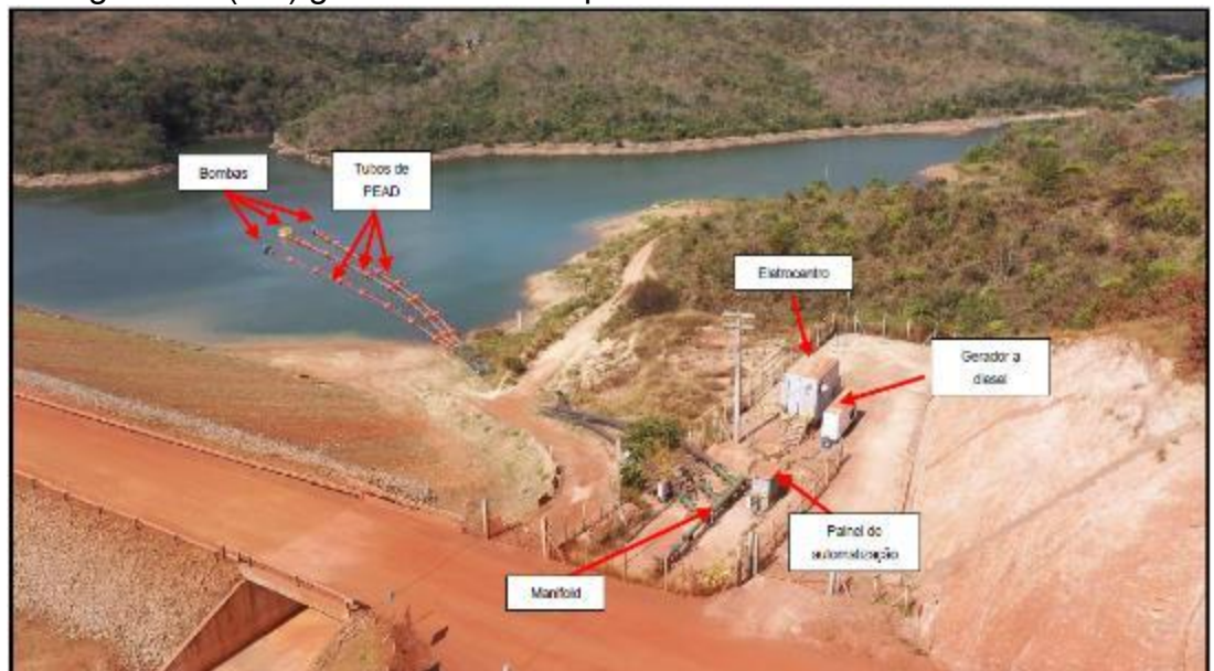
Figura 5- Estruturas para bombeamento
