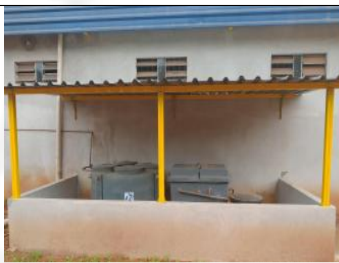
Figura 08: Caixa Separadora de Água e Óleo (Caixa SAO)
