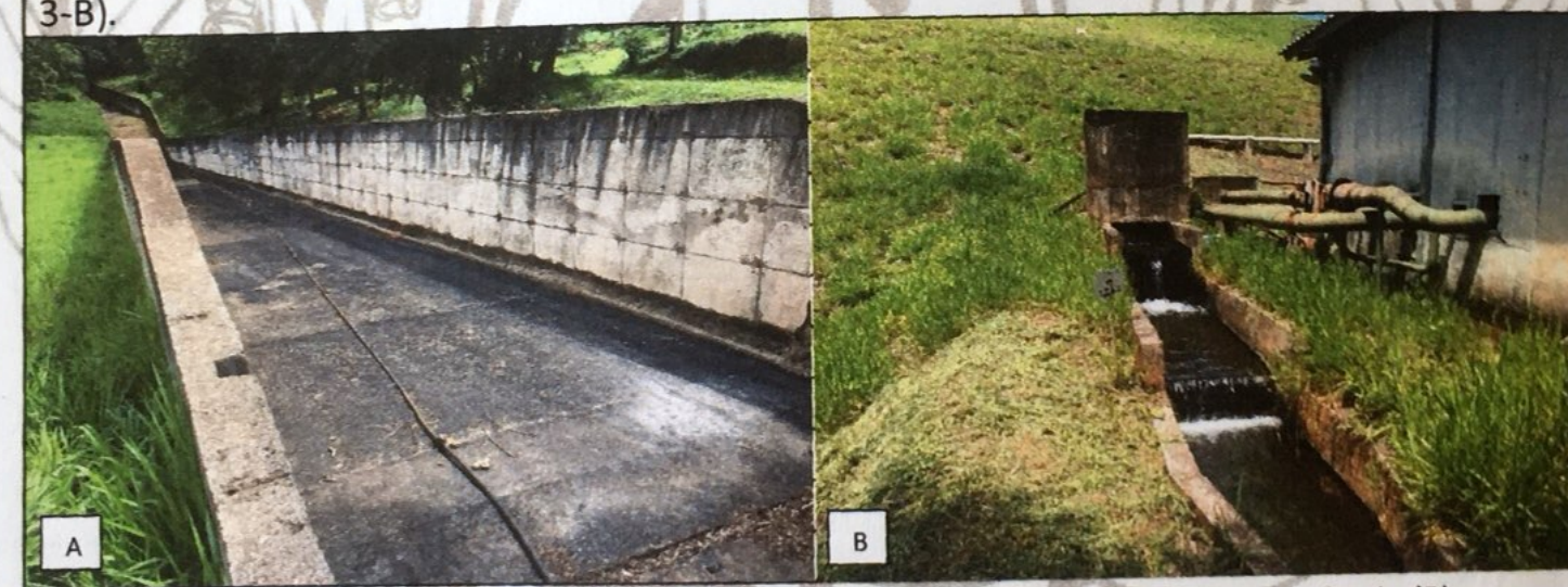
Figura 3: Vertedouro situado na ombreira direita (A). Água vertendo pela descarga de fundo (B).
