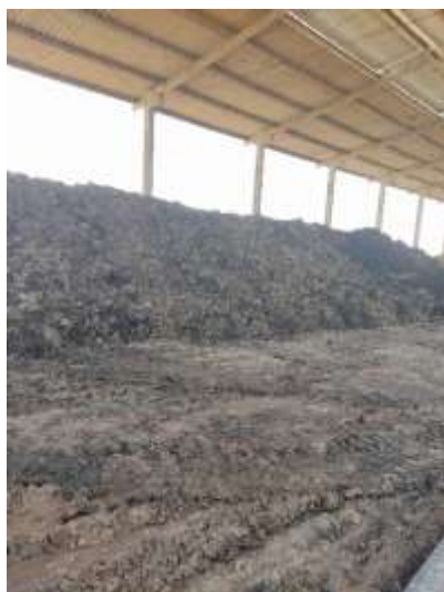
Foto 05. Galpão de compostagem de esterco
