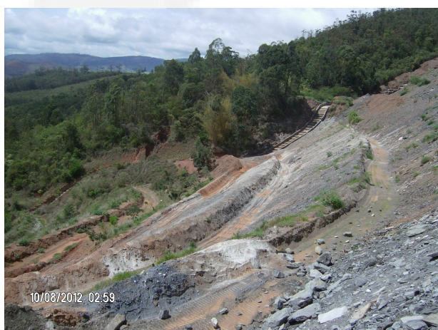
Foto 03 - Limite final da área de ampliação da PDE03 onde, ao fundo, pode ser observada a cerca do antigo paiol de explosivos..
