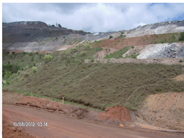
Foto 02 - Vista geral do flanco leste da PDE 03 que será envelopado pela ampliação.
