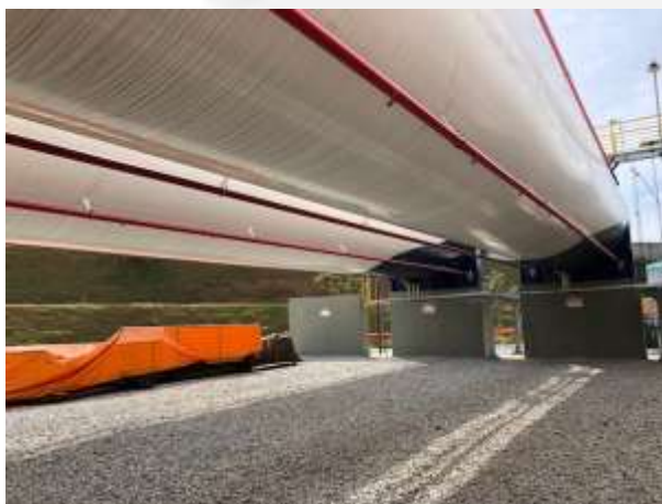
Foto 03. Vista inferior dos dois novos tanques.
