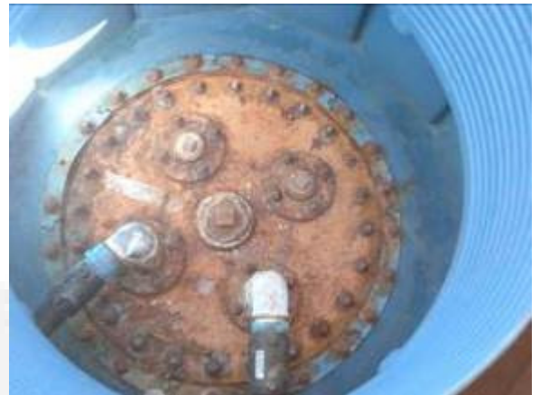
Foto 6. Boca de Visita de tanque
