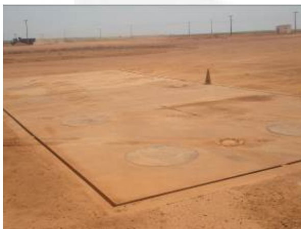
Foto 03. Área dos Tanques
