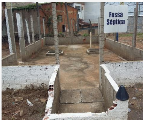
Figura 04: Fossa séptica com filtro anaeróbio.
