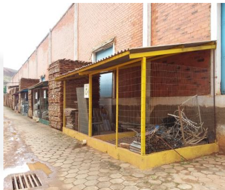
Figura 09: Depósito temporário de resíduos sólidos perigosos classe I
