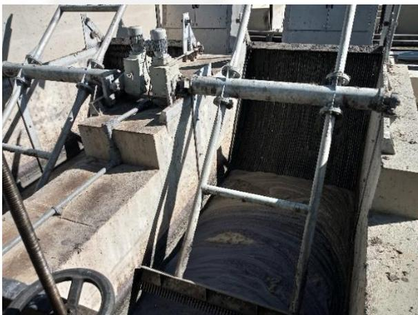
Foto 3: Gradeamento mecânico fino
