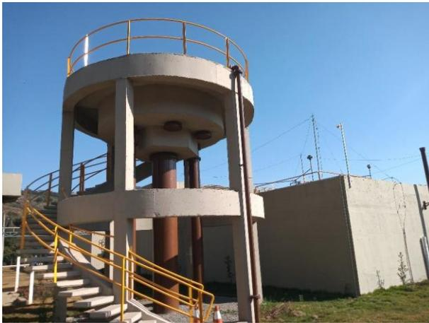
Foto 7: Caixa de distribuição de vazão
