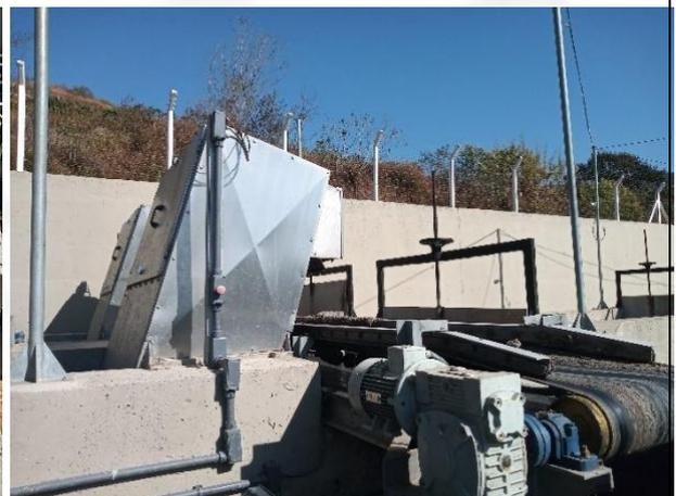
Foto 4: Peneira tipo STEP SCREEN e correia transportadora
