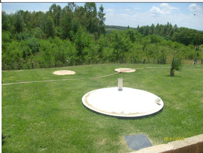
Foto 01. Fossa séptica implantada
