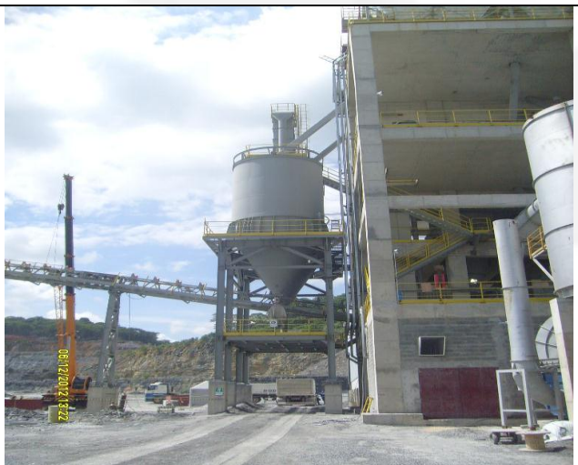
Foto 09: Silos de armazenagem
