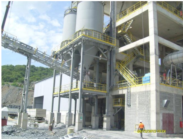
Foto 05: Vista geral da planta de moagem
