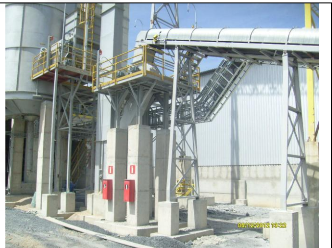
Foto 02: Silo de armazenamento
