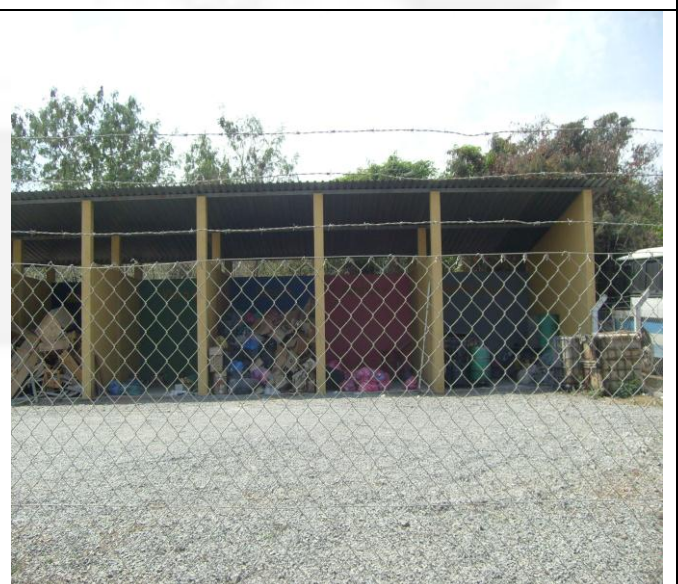
Foto 04: Depósito temporários de resíduos sólidos.
