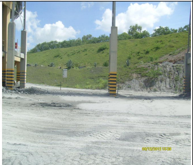
Foto 08: taludes revegetados em cumprimento da condicionante 11 da LI.
