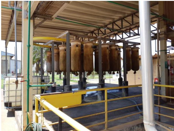
Foto 05. Área de secagem do lodo
