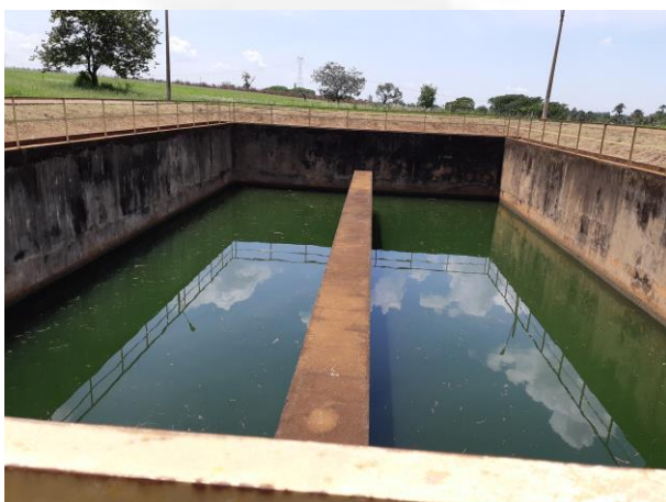
Foto 09. Tanque de águas pluviais
