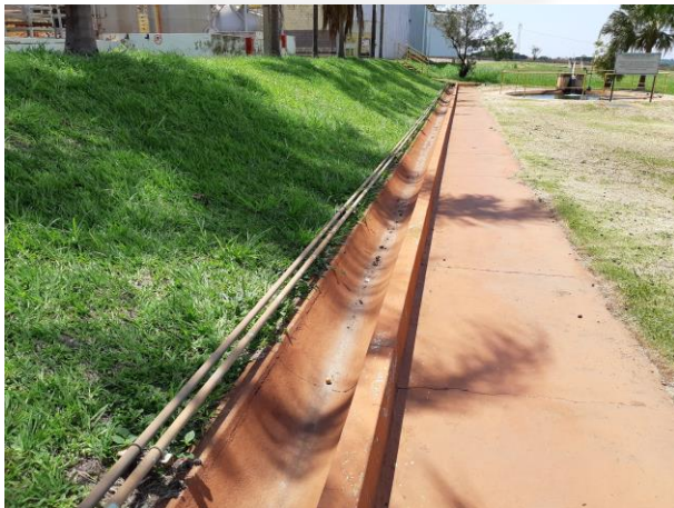
Foto 07. Canaleta de água pluvial
