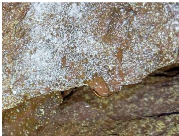
Foto 47. Gotejamento na cavidade BR_0043.
