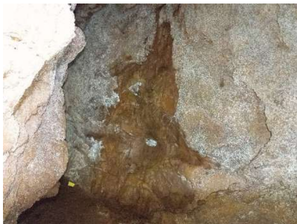
Foto 41. Escorrimento e feição de escorrimento na BR_0043.
