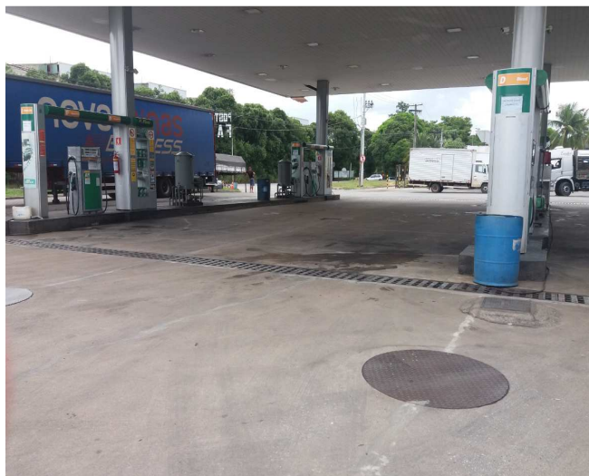
Foto 01: Visão geral da pista de abastecimento.
