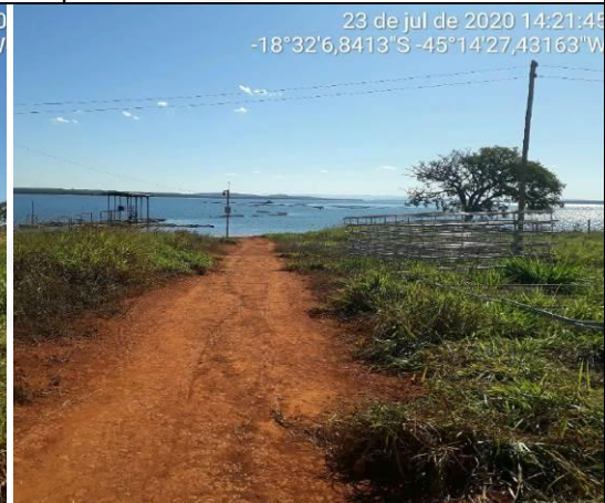
Foto 04. Vista da estrada antiga em APP que será recuperada - área do PTRF.
