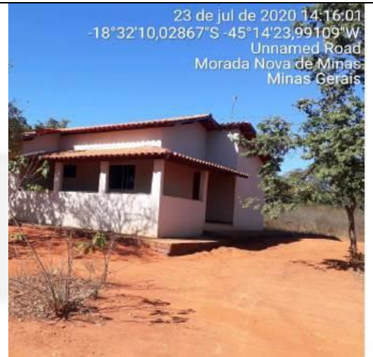
Foto 02. Vista da infraestrutura do empreendimento – casa sede.
