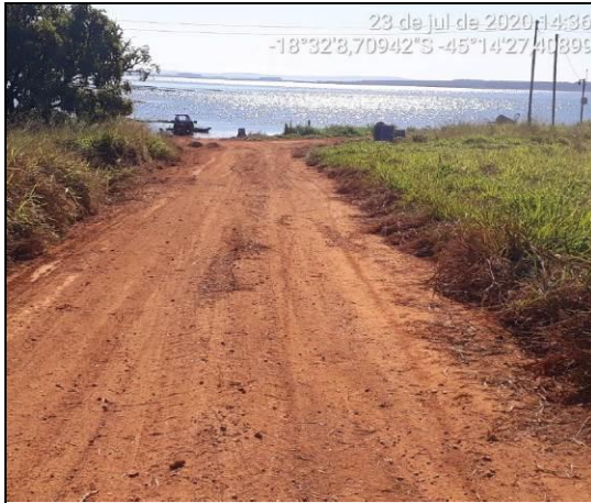
Foto 01. Rampa de acesso ao reservatório – objeto de simples declaração.
