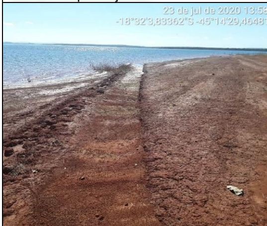
Foto 05. Vista da curva de nível para controle de erosão.
