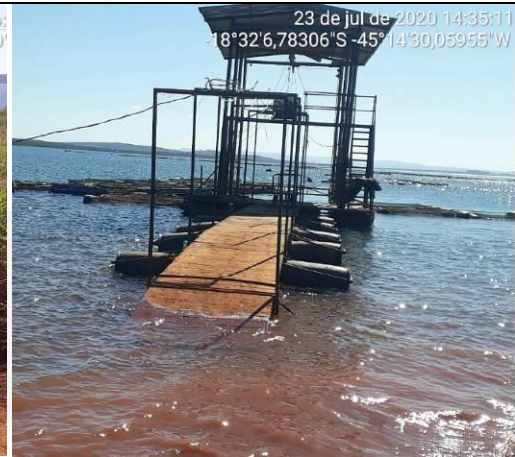
Foto 02. Plataforma de manutenção e de despesca.
