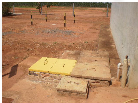
Foto 04. Caixa separadora de água e óleo.
