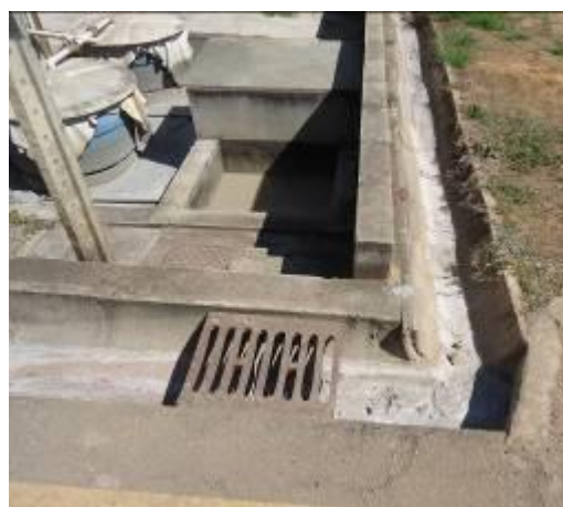
Foto 10. Sistema de drenagem pluvial.
