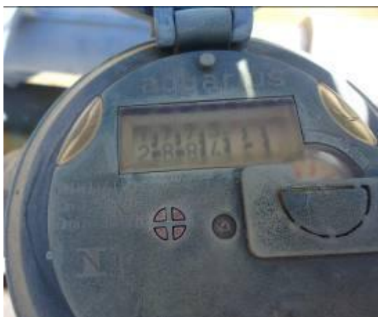
Foto 09. Hidrômetro instalado no poço tubular.
