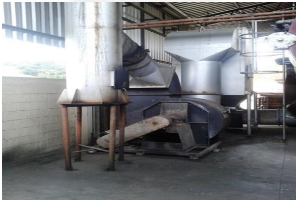
Figura 1: sistema de ciclone anti-fuligem
