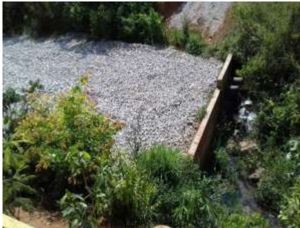
Foto 05. Tratamento passivo Barragem Eustáquio
