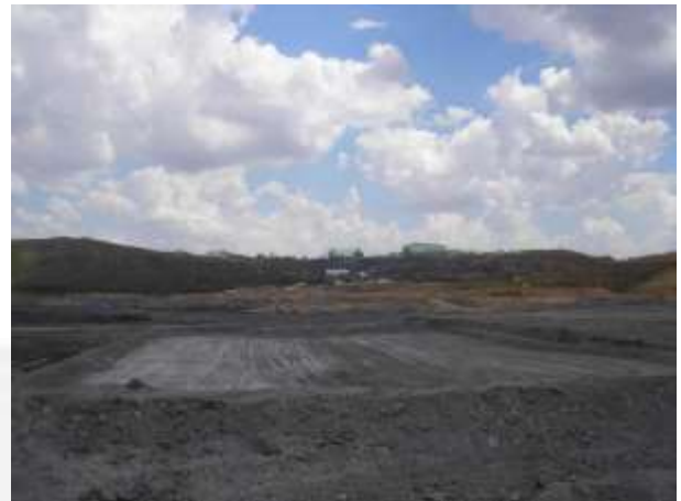
Foto 04. Reaproveitamento de rejeito (Barragem Santo Antônio)
