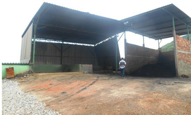
Foto 01. Galpões para armazenagem de pó de balão e argila.
