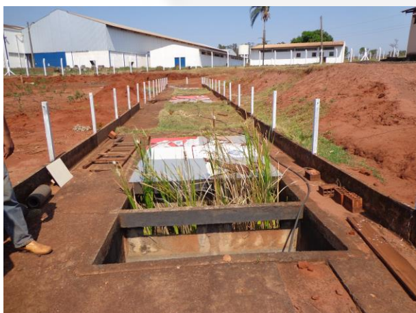
Foto 09. Tanques de tratamento de efluentes.
