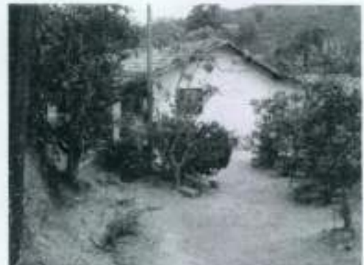
Figura 62 -- Detalhe da entrada de uma residência.
