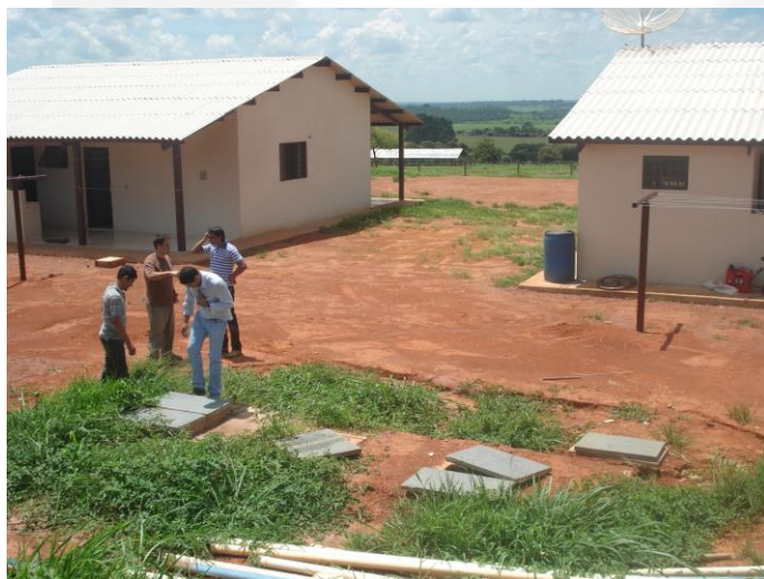
Casa dos funcionários - Sistema Fossa Séptica
