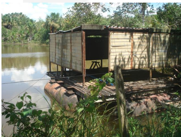
Captação em barramento com regularização de vazão.
