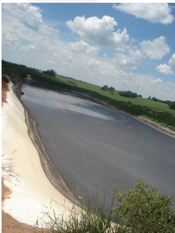
Lagoa de Retenção
