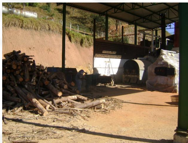
Foto 04. Depósito de lenha e caldeiras
