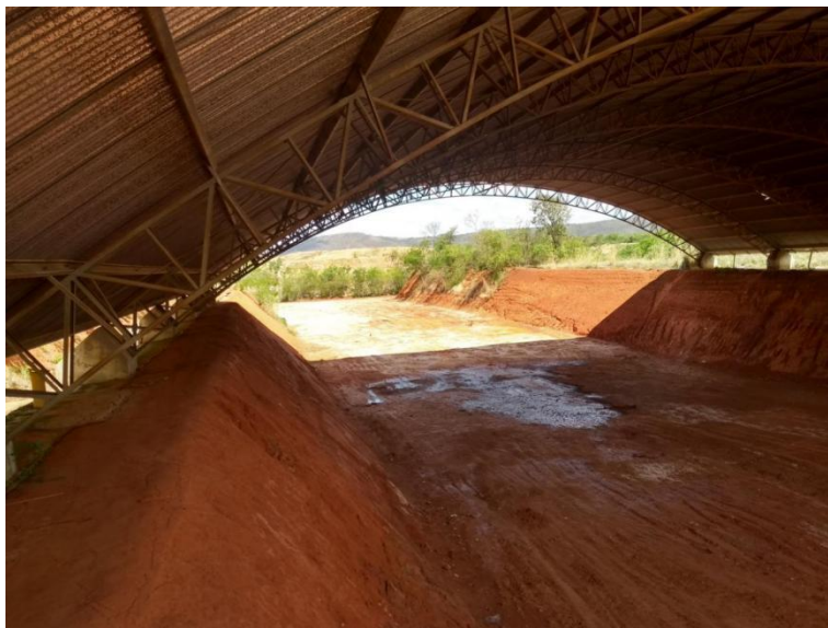
Foto 13 - Aterro para resíduos industriais desmobilizado. - Fonte: Vistoria
