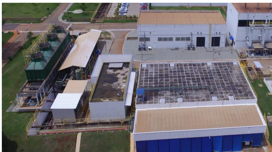
Foto 4 - Sistema de resfriamento industrial. - Fonte: RADA
