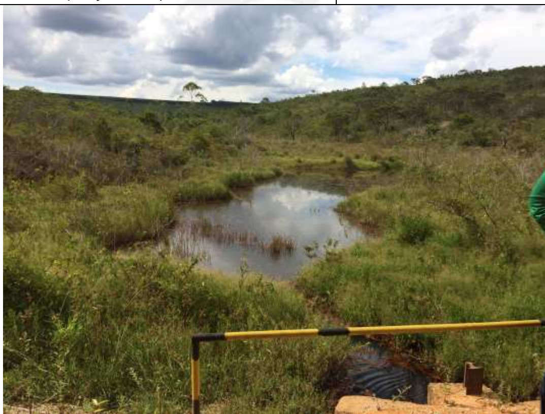
Foto do barramento a ser regularizado
