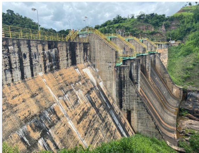
Figura 5: Barragem Guanhães. Fonte: SUPPRI, 2020
