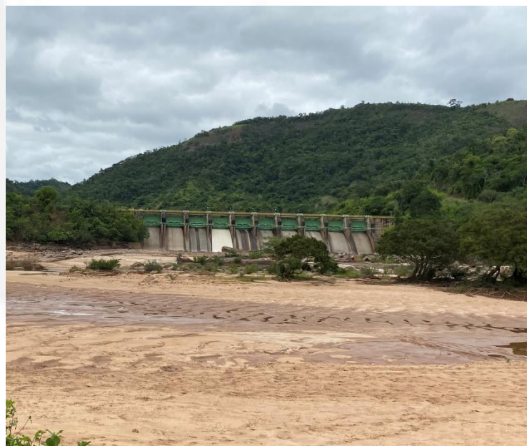
Figura 4: Barragem Santo Antônio. Fonte: SUPPRI, 2020
