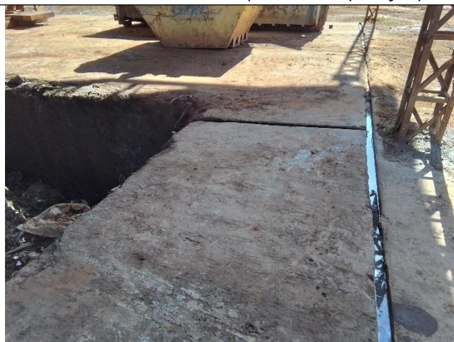
Foto 04: Canaletas para captação de efluentes (galpão de blindagem de resíduos)
