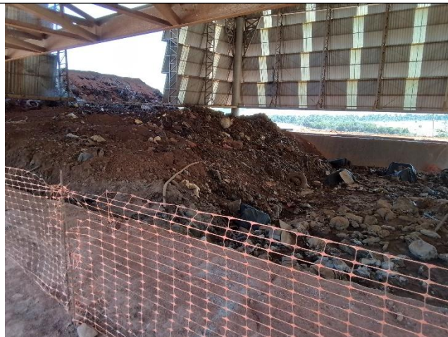
Foto 02: Aterro classe I (célula em operação)
