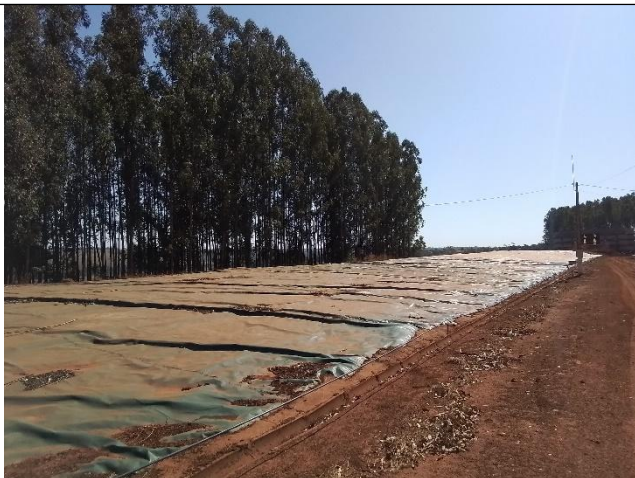
Foto 01: Aterro classe I (célula encerrada)
