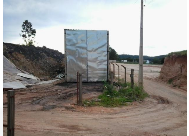
- Depósito de pó de balão.
