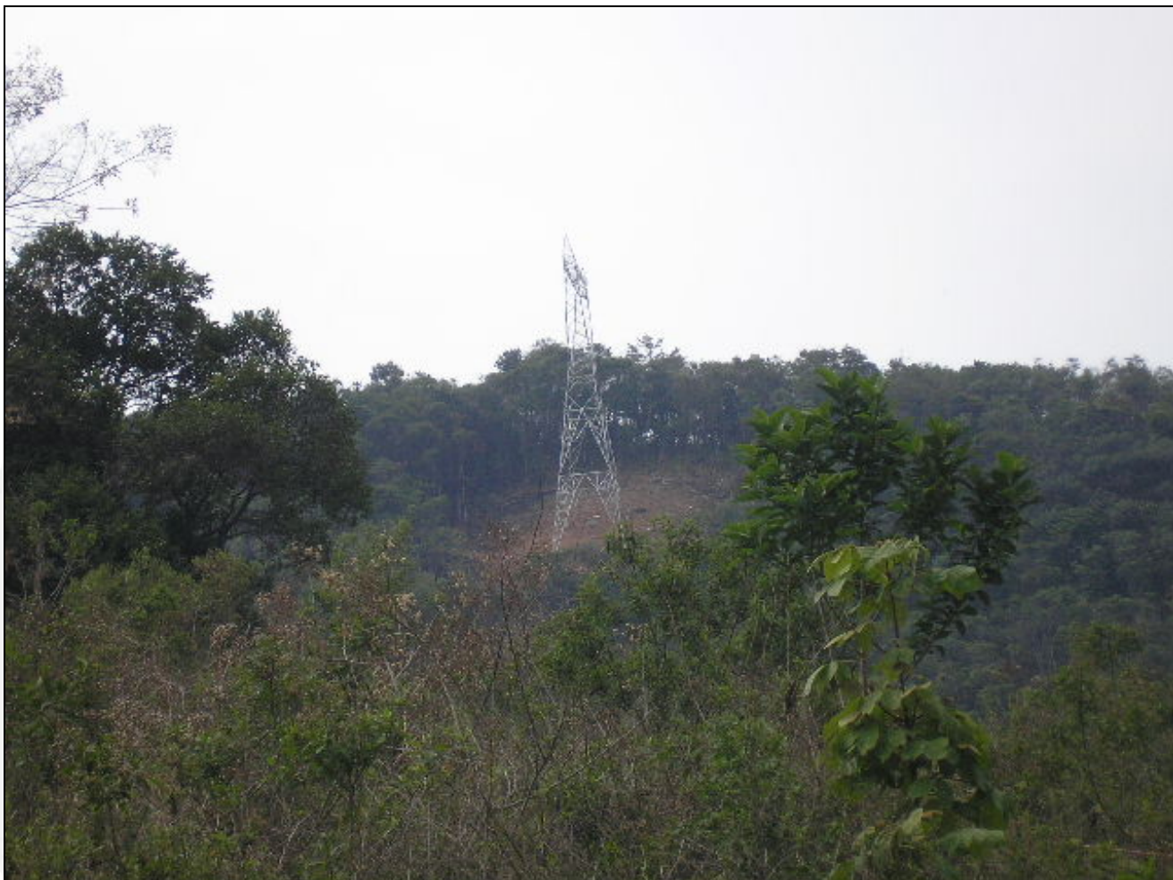
Foto 03: Torre instalada de Helicóptero onde não foi necessária a via de acesso a veículos pesados.
