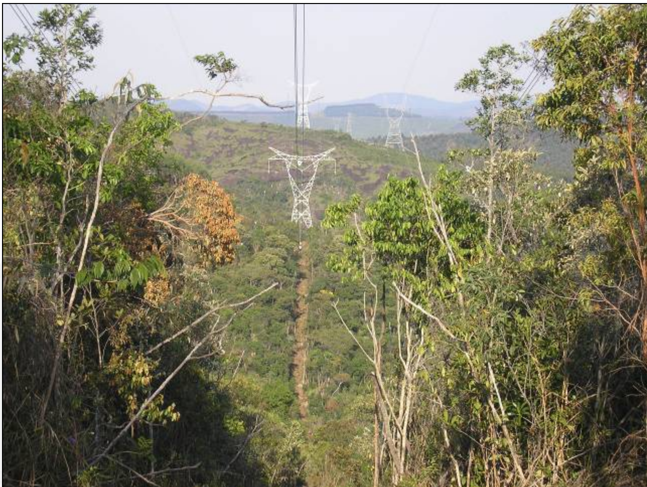
Foto 02: A abertura de uma faixa de 3m foi necessária para o içamento dos cabos transmissores.
