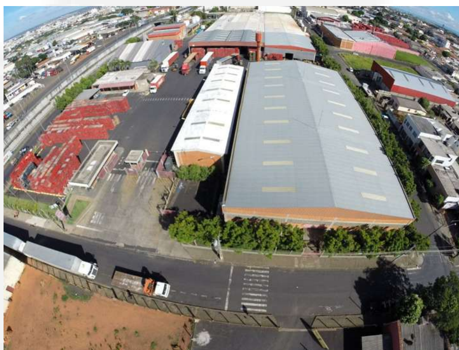
Figura 02: Vista aérea do empreendimento “Uberlândia Refrescos Ltda.”.
