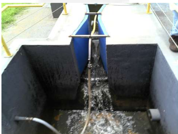
Foto 07: saída da ETE; 23/12/2016.
