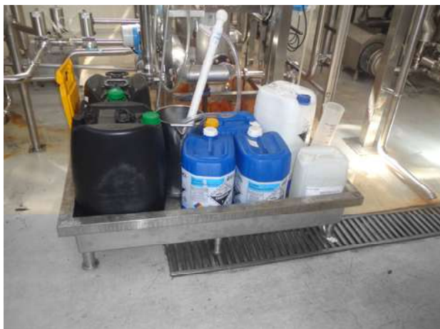
Foto 11: produtos químicos utilizados com estrutura de contenção; 23/12/2016.
