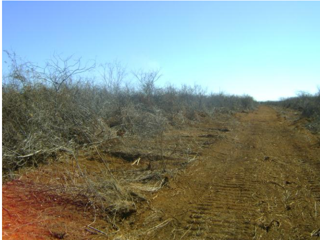
Foto 01. Área com demarcação do raio do Pivô 6001
