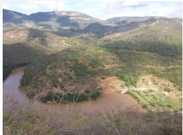
Vista do dique existente em nível de água máximo normal (cota 626 m)
