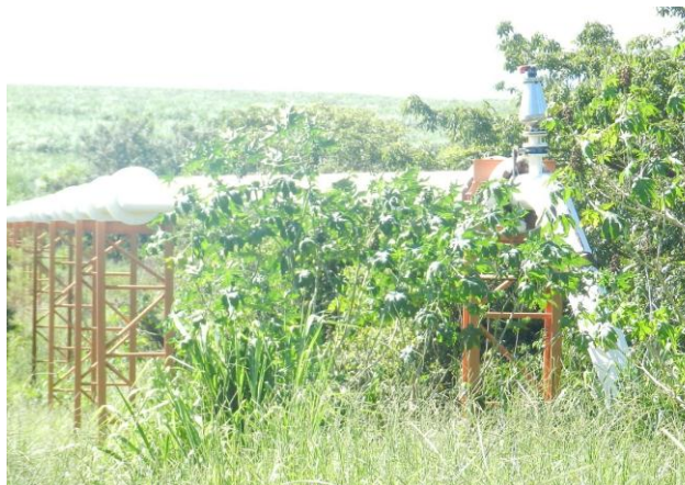
Figura 5- Adutora que substituiu tubulação quebrada.
