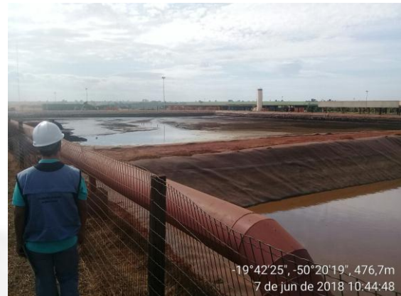
Figura 9 – Tanque de vinhaça impermeabilizado e aplicação de vinhaça em área agrícola.
