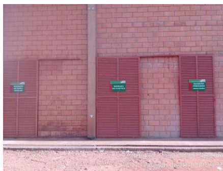
Figura 14- Local de armazenamento temporário de resíduos.
