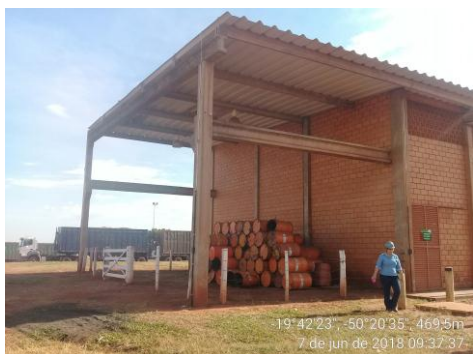
Figura 13- Local de armazenamento temporário de resíduos.
