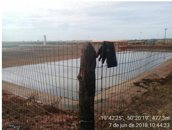
Figura 9 – Tanque de vinhaça impermeabilizado e aplicação de vinhaça em área agrícola.
