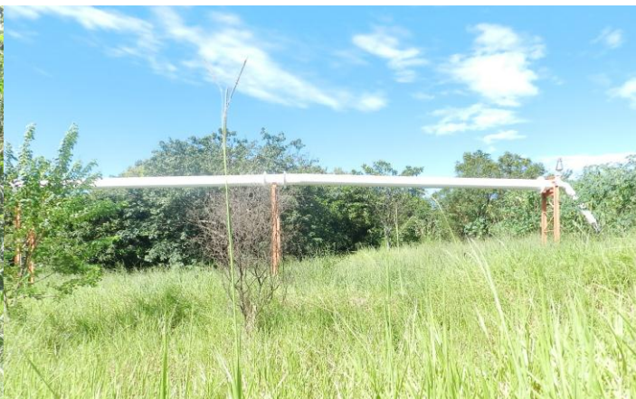
Figura 6- Adutora que substituiu tubulação quebrada.
