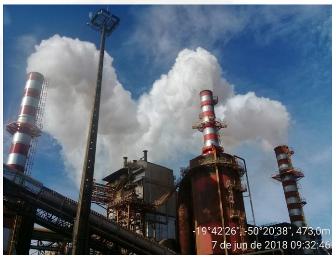
Figura 18- Caldeira utilizada na queima do bagaço de cana-de-açúcar.
