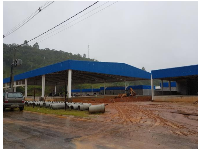
figura 2: empreendimento em fase de instalação
