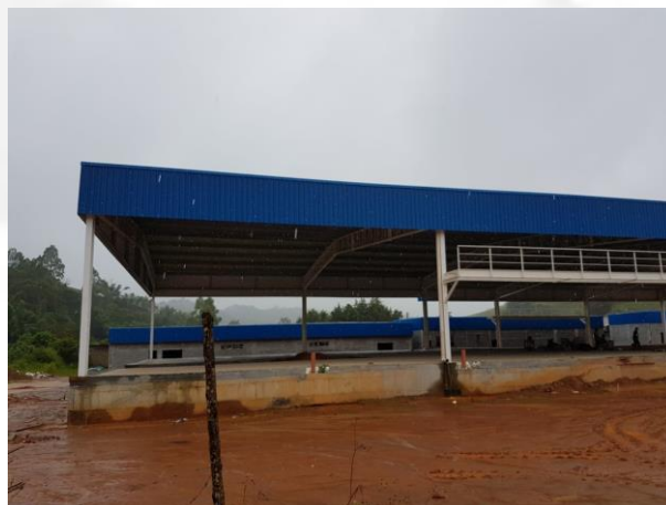
figura 3: edificação em obras
