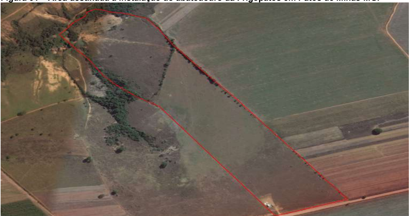
Figura 01 – Área destinada à instalação do abatedouro da Frigopatós em Patos de Minas-MG.
