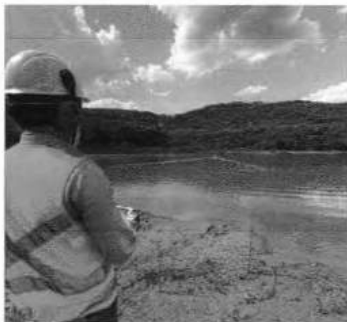
Imagem 02 – Execução Levantamento Batimétrico – DIQUE LISA
