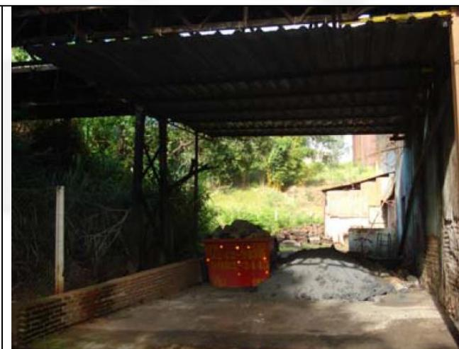
**Foto 4.** Área de armazenagem da areia de fundição, com piso impermeável, baia de contenção e teto coberto.
