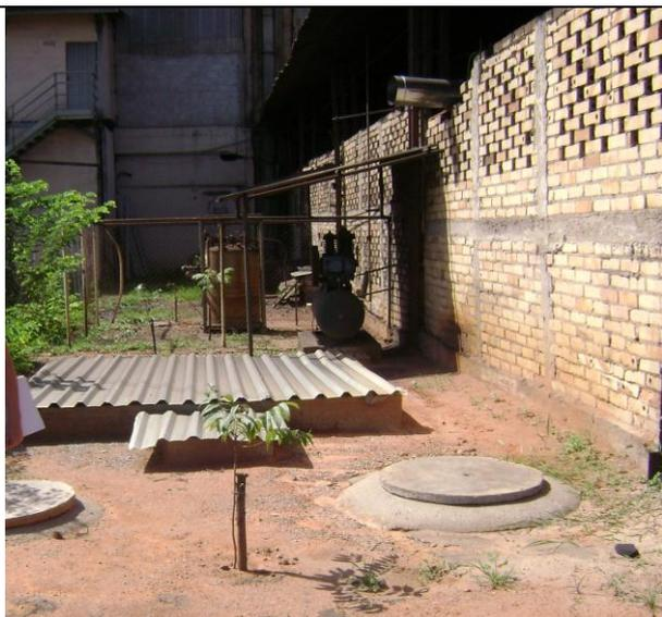
**Foto 07.** Sistema de Tratamento de Efluente líquido sanitário, composto de fossa séptica, filtro anaeróbico e sumidouro.
