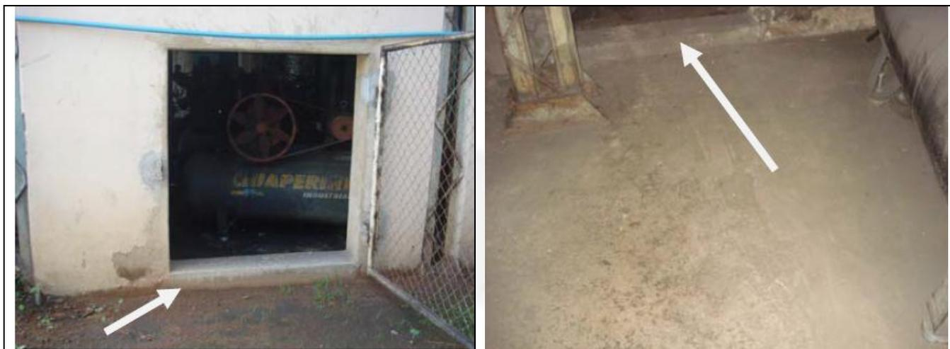
**Foto 05.** Compressor com bacia de contenção e piso impermeável
