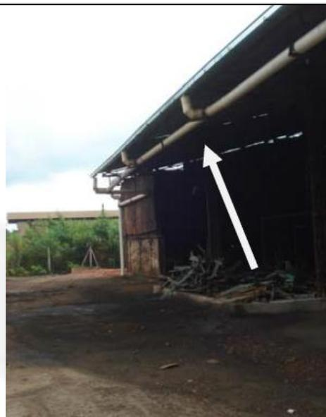
**Foto 08.** Captação de água dos telhados, através de canaletas.
