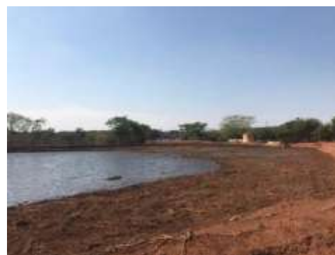
Foto 06. Reservatório de vinhaça não impermeabilizado que será desativado
