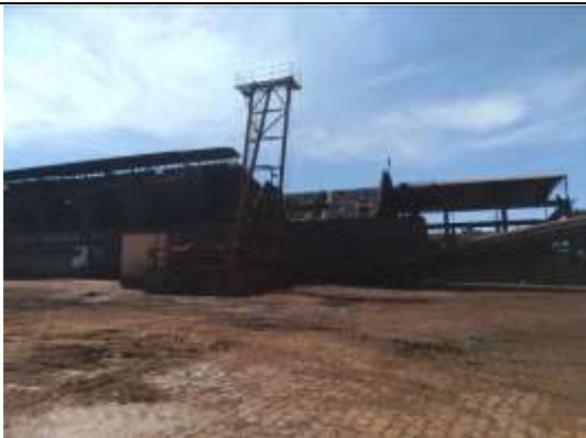
Foto 01. Descarregamento da cana de açúcar
