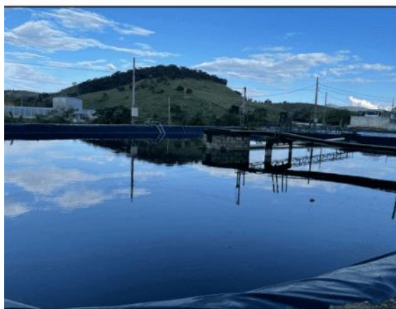
Figura 03: – Lagoa de decantação
