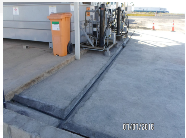
Foto 02. Canaletas da área de abastecimento
