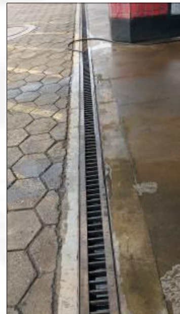
Foto 02. Canaletas ao redor da pista de abastecimento.
