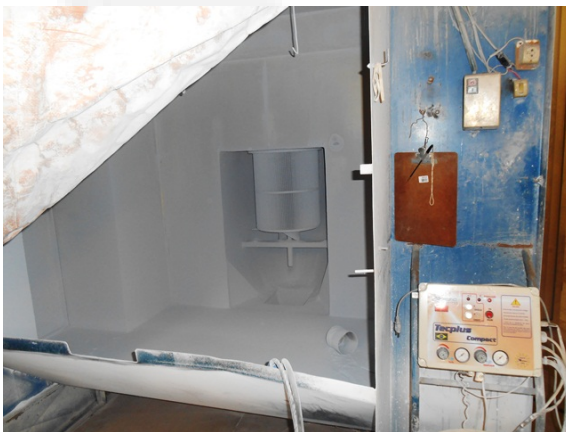
Foto 03. Área de pintura com exaustor e filtro
