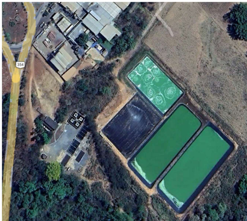
Figura 2- Estruturas da nova Estação de Tratamento de Efluentes. Fonte: Google Earth (acesso em 2026)
