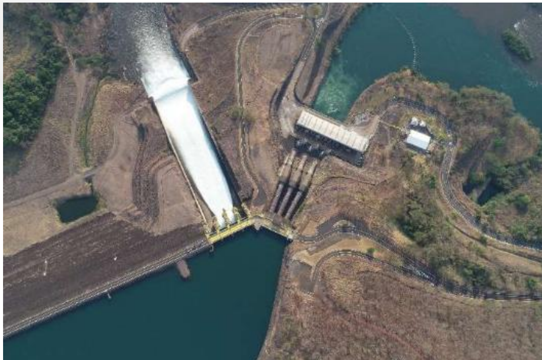
Figura 02: Panorâmica da casa de força e barramento. Fonte: Pacuera - UHE Miranda (2021).
