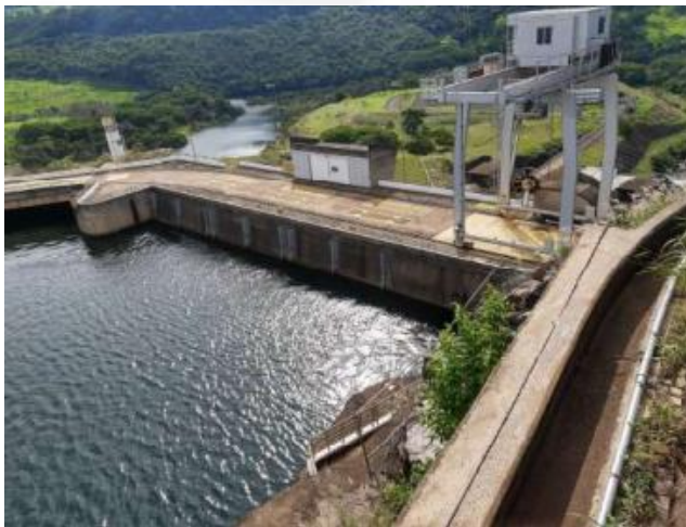
Foto 03: Comporta da Tomada d'água.
