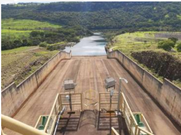
Foto 05: Rampa do Vertedouro
