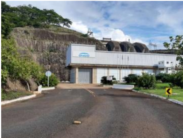
Foto 07: Entrada da Casa de força
