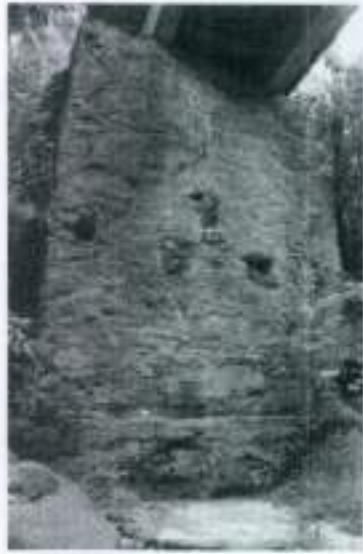
Figura 48 - Fundação e muro da ponte sobre o Ribeirão Mata Cavalos. Sítio Arqueológico Histórico Ponte do Mata Cavalos. Foto Digital – Jan. 2013. Fonte: Rogério Tobias Júnior.
