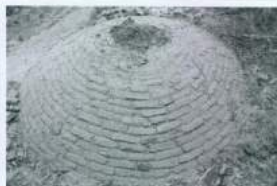
Figura 51 - Vista da Cúpula do forno próximo a cava sul. Foto Digital – Jan. 2013. Fonte: Rogério Tobias Júnior.
