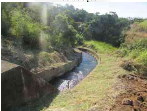
Foto 08 e 09. Canal do dreno de fundo da barragem BL-1 que será prolongado.
