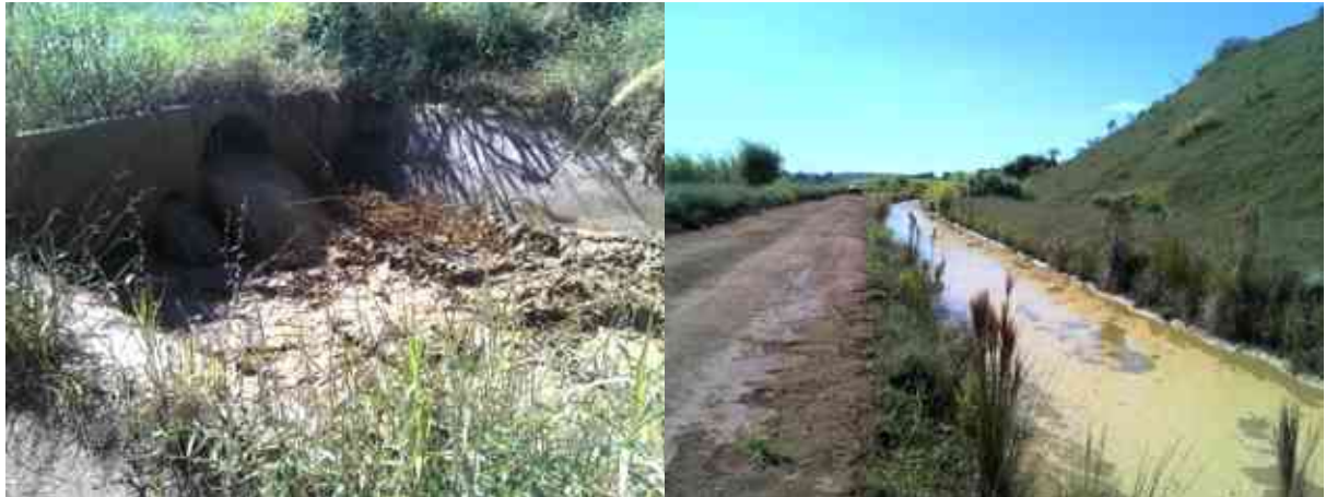
Foto 10 e 11. Canal de lamas para barragem BL-1.
