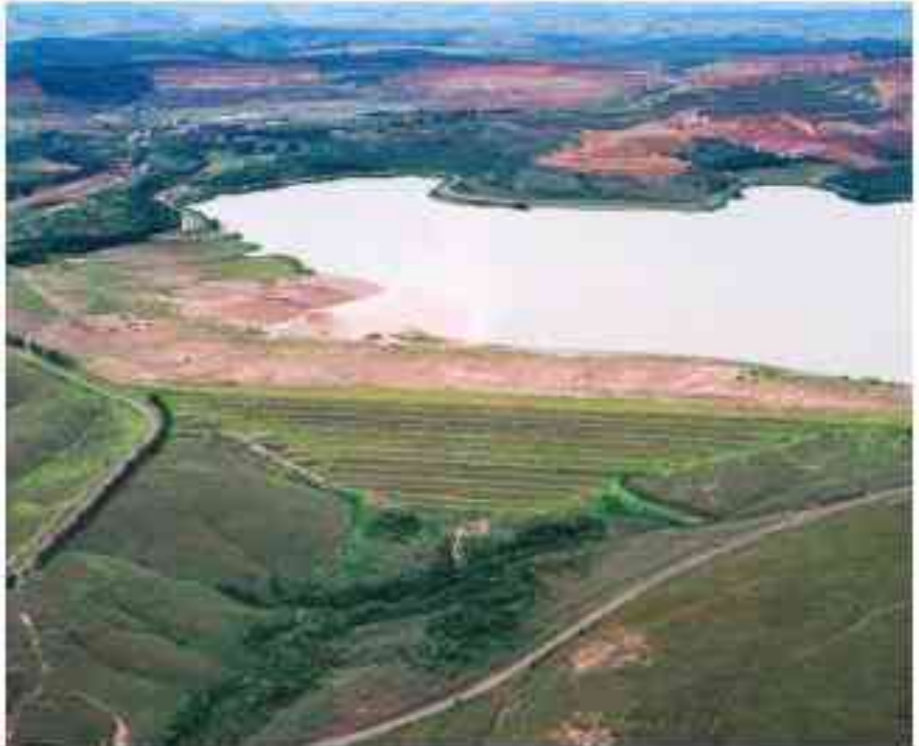
Foto 01. Visão da Barragem BL-1.
