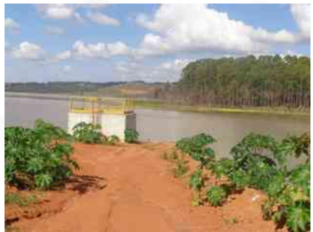
Foto 07. Torre extravasora da BL-1 que substituída no alteamento final.
